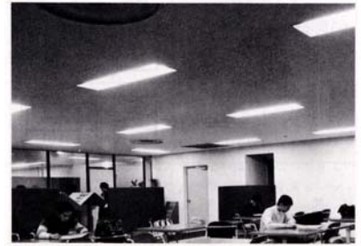
図7.19 アンビエント照明の例
